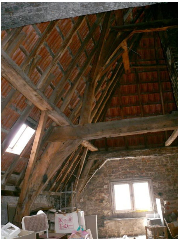
De kapconstructie richting de voorgevel
