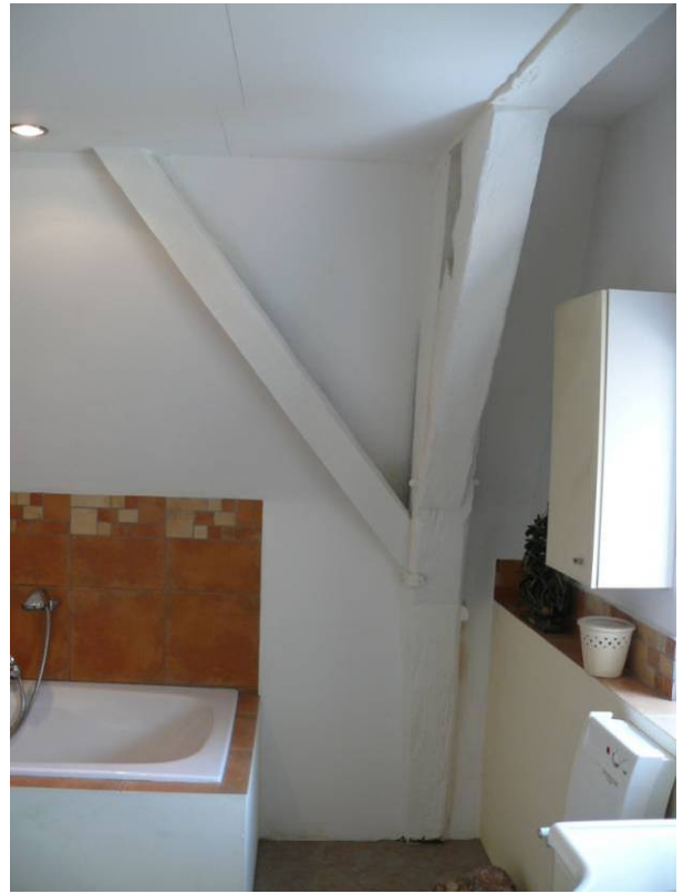
Achterste strijkspant op de eerste kapverdieping
