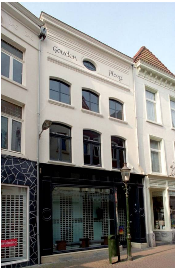
De voorgevel van Gasthuisstraat 10
