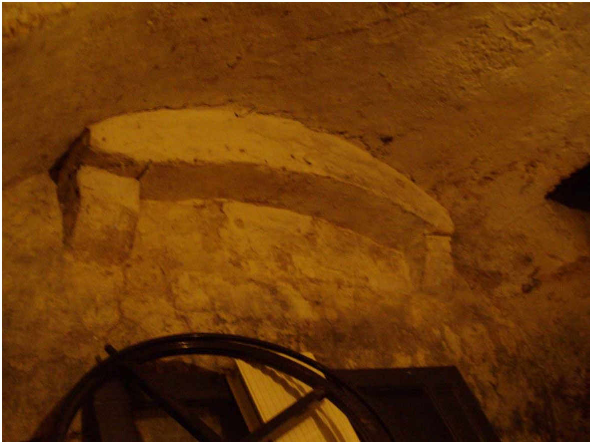
Restant van een ondersteuning van schouw op de begane grond, onder het gewelf van de achterkelder
