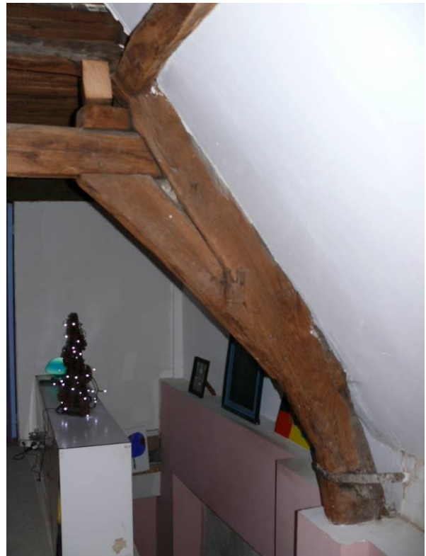
Eiken tussenbalkjuk op zolderniveau van het achterhuis
