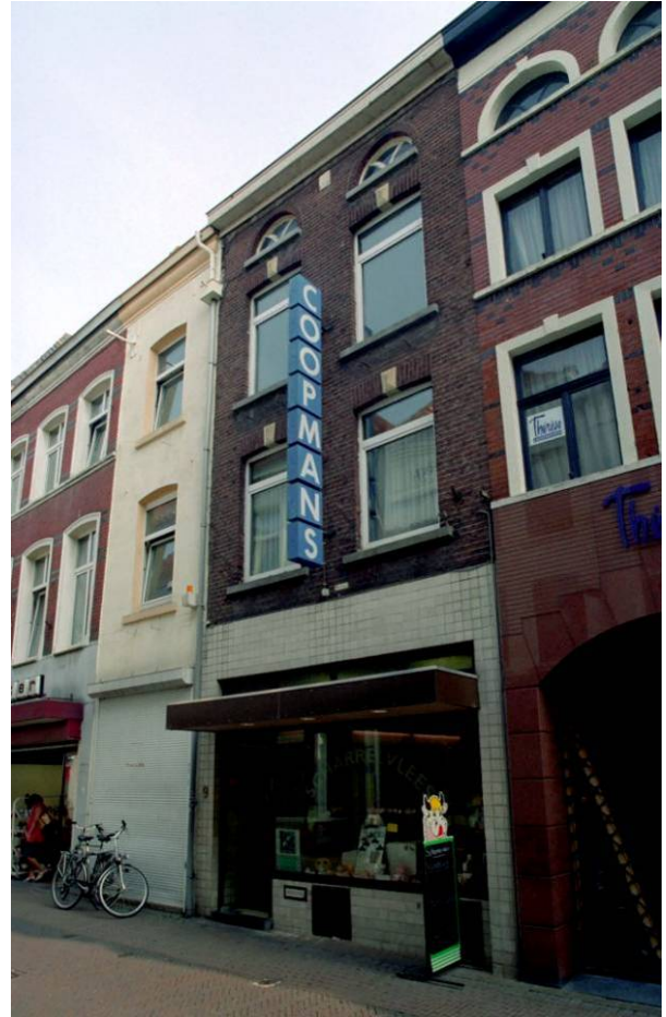
De voorgevel van Gasthuisstraat 9
