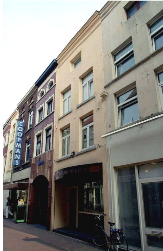
de voorgevel van Gasthuisstraat 13
