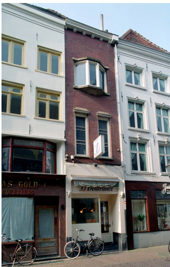
De voorgevel van Gasthuisstraat 4
