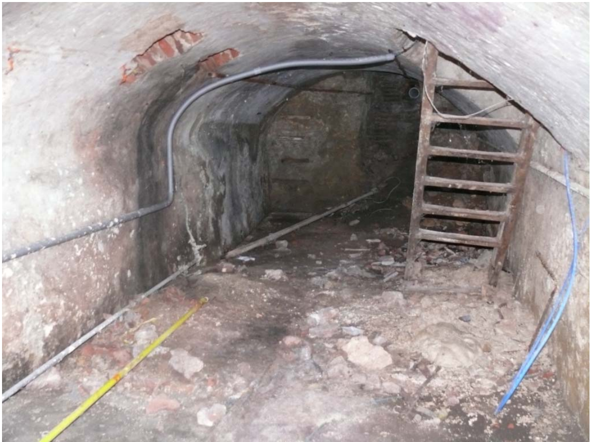
De kelder van Gasthuisstraat 11 richting de achtergevel
