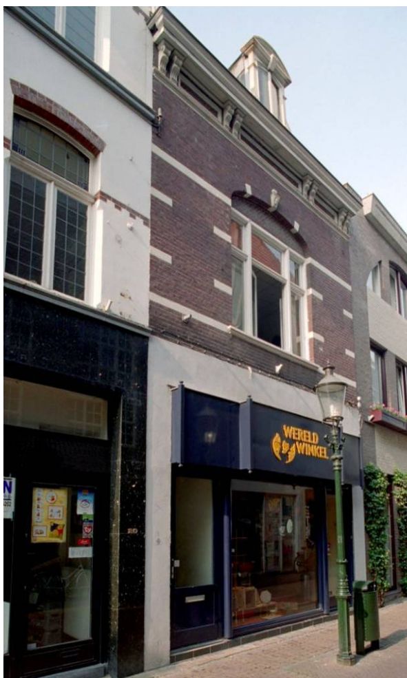
De voorgevel van Gasthuisstraat 18
