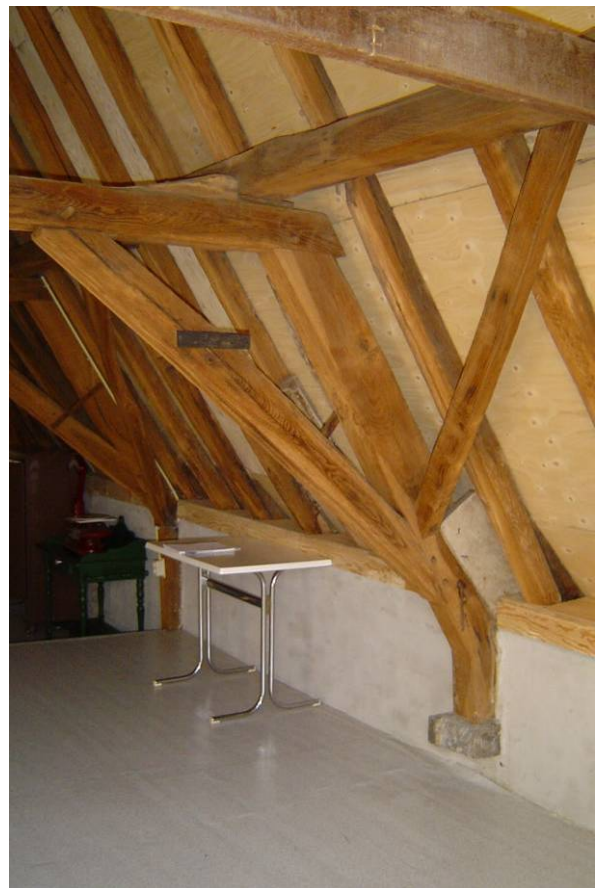
Ingekort spantbeen op hardstenen console
