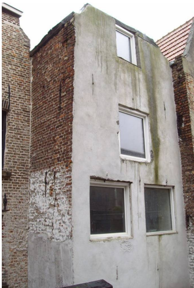
De achtergevel van Gasthuisstraat 12
