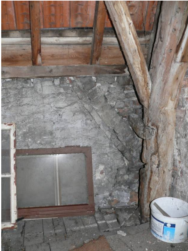
Schuine dakaanzet van buurbouw in oostgevel
