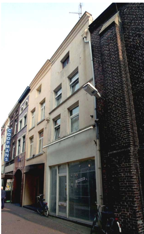
De voorgevel van Gasthuisstraat 15
