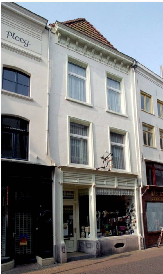
De voorgevel van Gasthuisstraat 8
