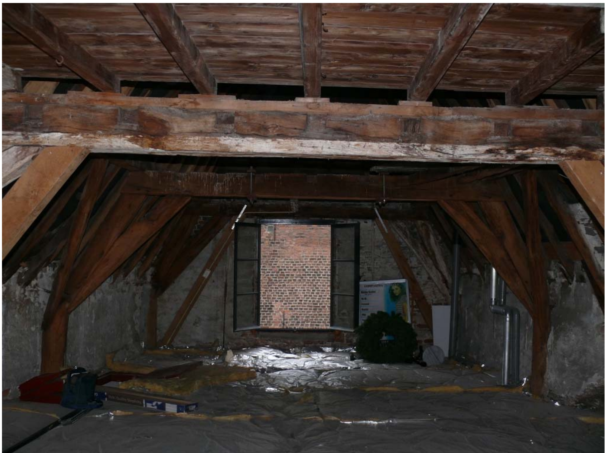
De kapconstructie van Gasthuisstraat 10 richting de achtergevel
