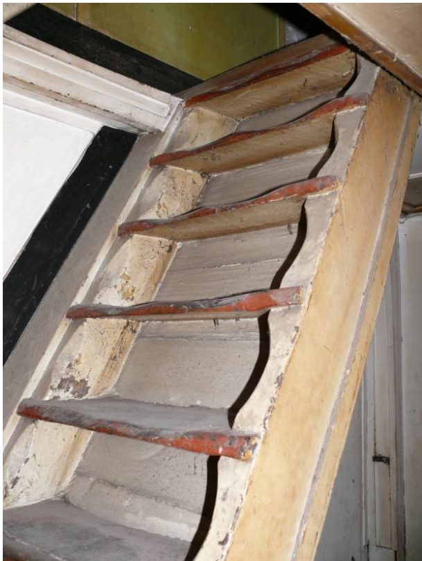
De eiken steektrap naar de zolderverdieping
