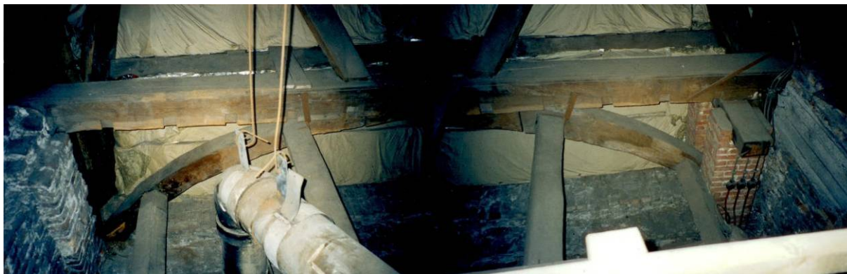
Trekbal boven het schip van de kapel, bij de aansluiting met het koor, eronder de eiken boog van het verdwenen achttiende-eeuwse tongewelf
