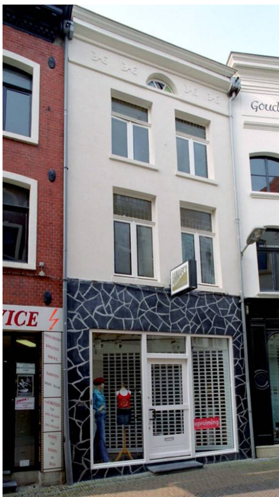
De voorgevel van Gasthuisstraat 12
