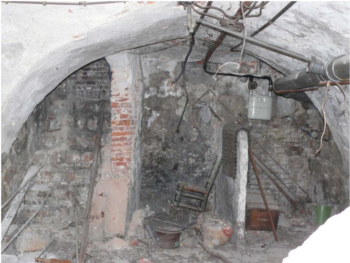
De voorkelder richting voorgevel met links de oorspronkelijke ingang
