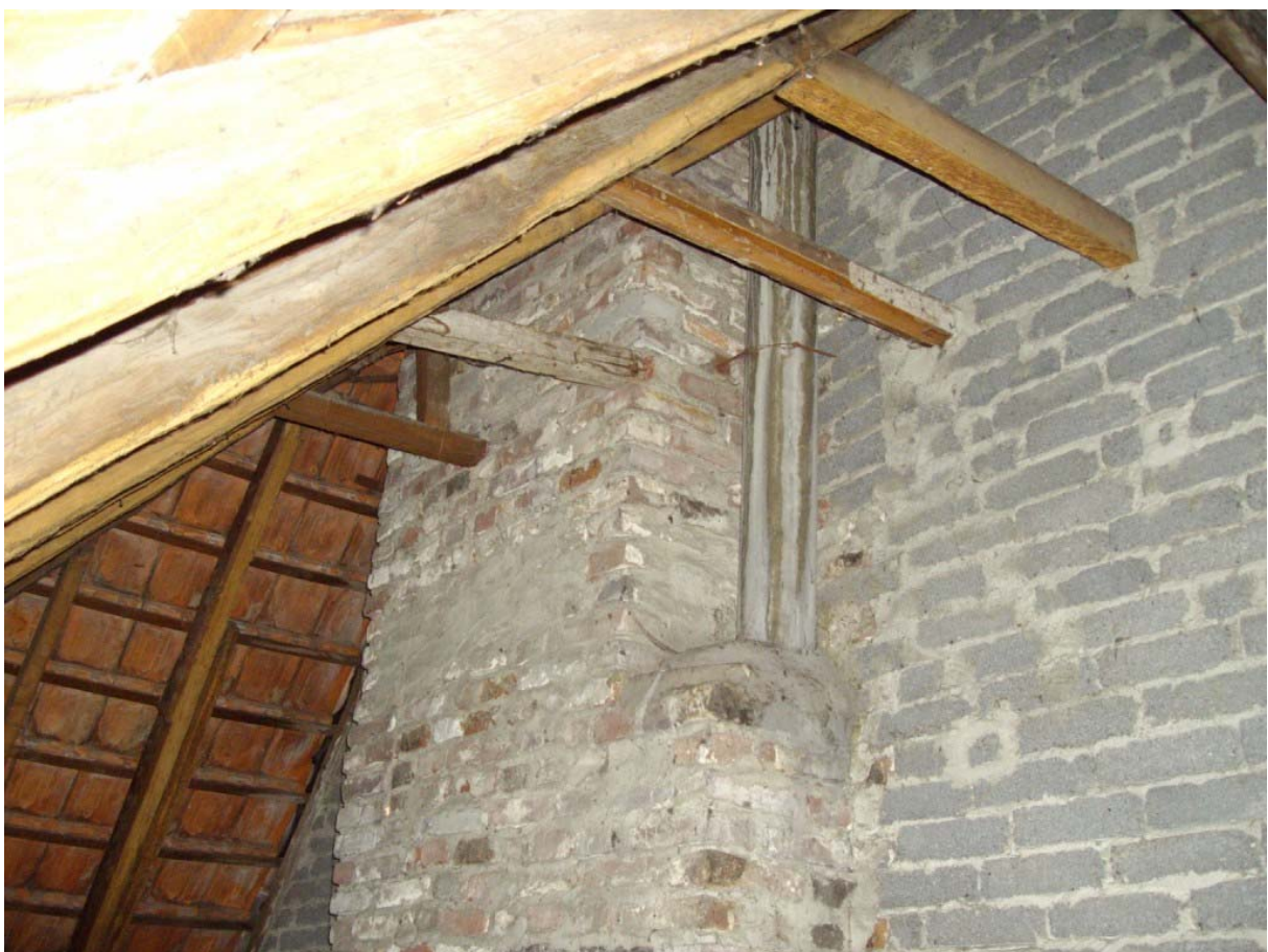
Eiken sporenparen, waarvan de haanhouten door de tussenmuur met nr.20 steken
