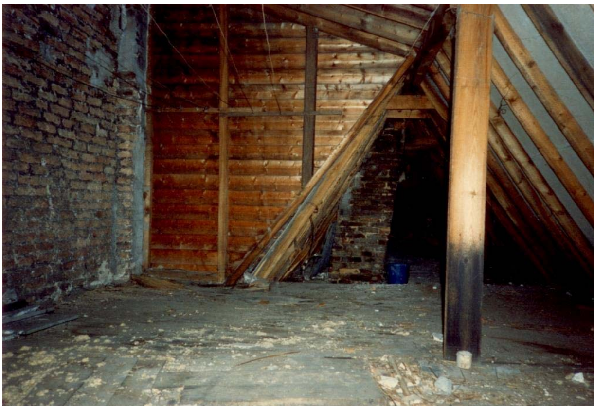
De zolderruimte van het voorhuis van Gasthuisstraat 18 richting de aansluiting met het achterhuis, foto 1987
