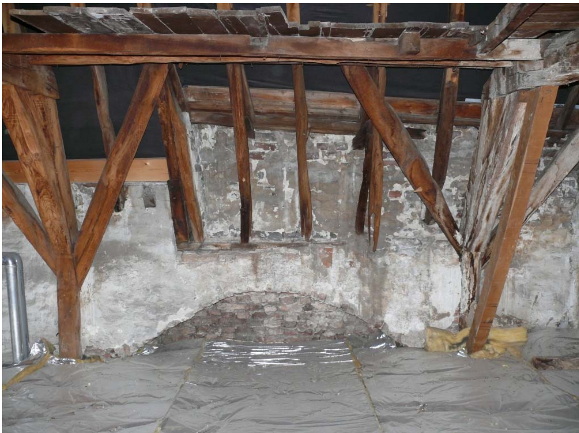
De spaarboog in de oostelijke zijmuur op de kapverdieping
