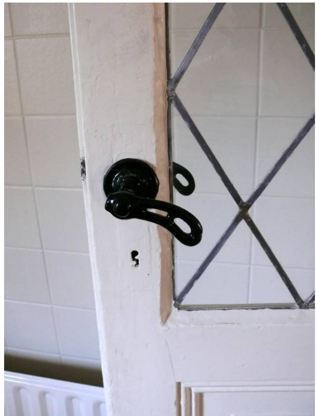
Laatnegentiende-eeuwse deur op de eerste verdieping
