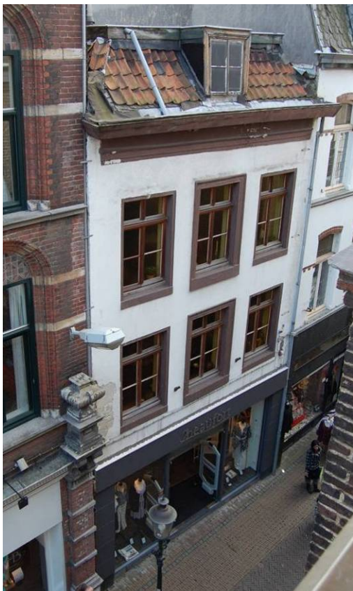
De voorgevel van Gasthuisstraat 22
