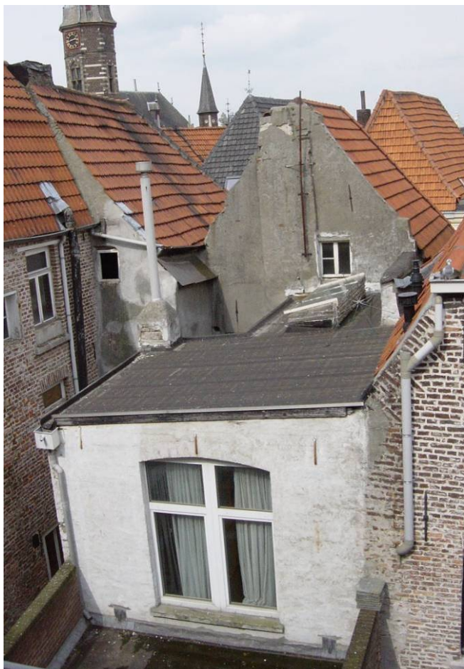
De achtergevel en achterbouw van Gasthuisstraat 8
