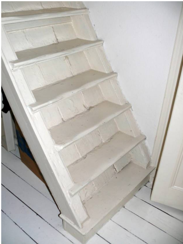
Eiken steektrap naar de zolderverdieping
