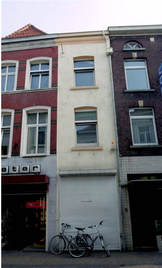
De voorgevel van Gasthuisstraat 7
