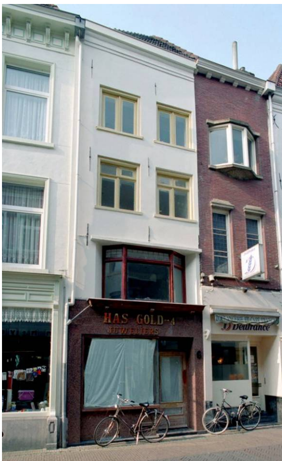
De voorgevel van Gasthuisstraat 6
