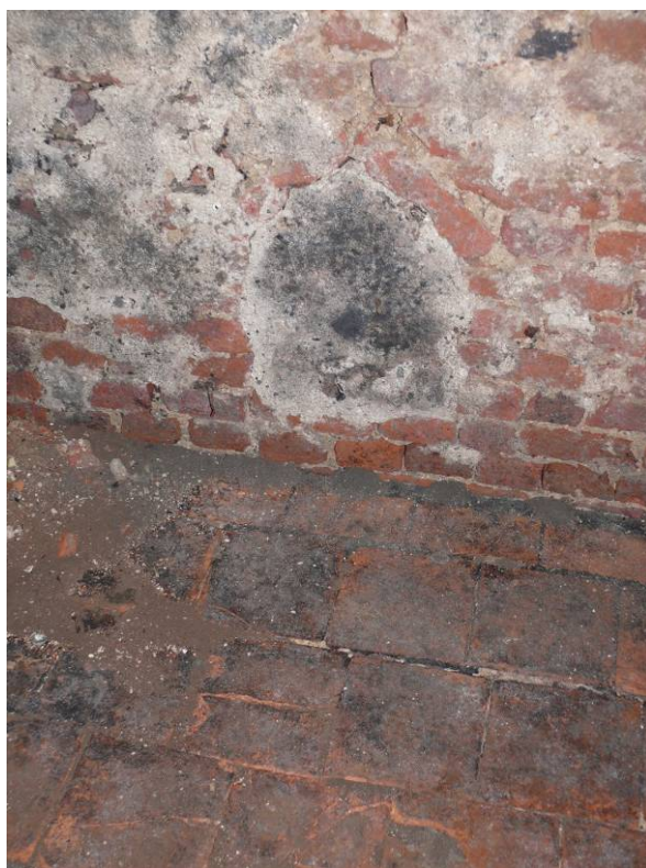
Dichtgezette kaarsnis in de oostgevel van de kelder
