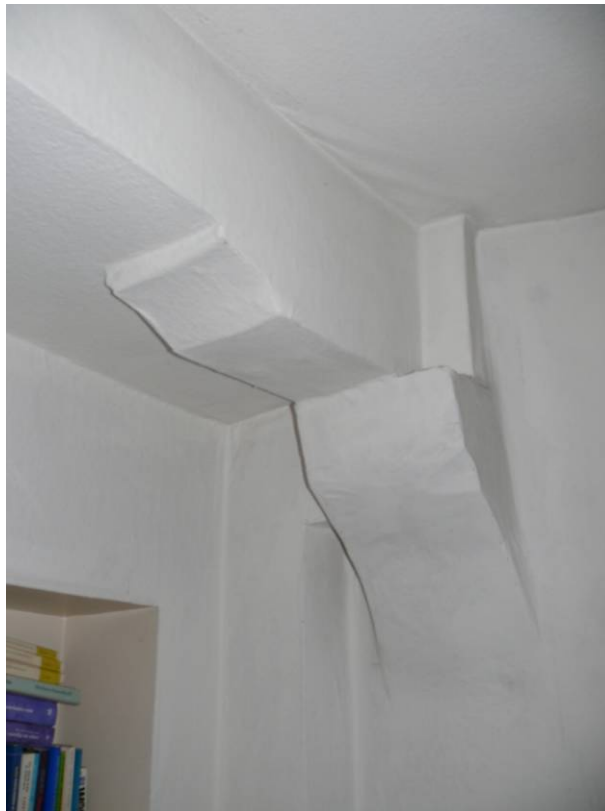
Moerbalk met slof en console op de tweede verdieping
