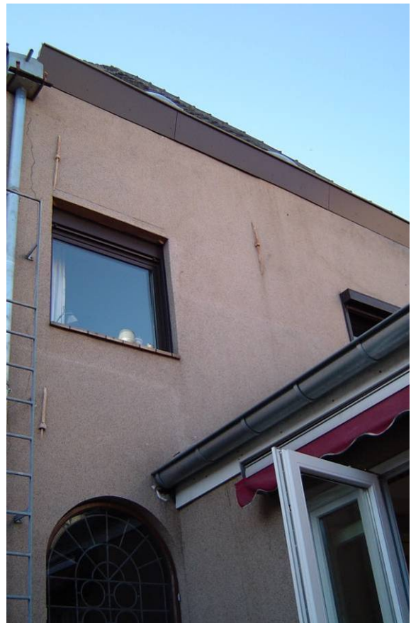
De achtergevel van Gasthuisstraat 3
