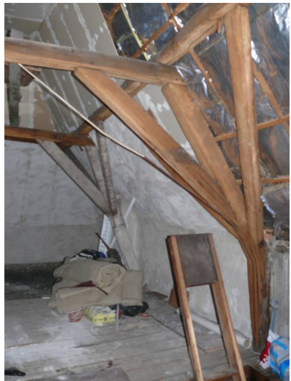
De voorste spantbenen aan de westzijde
