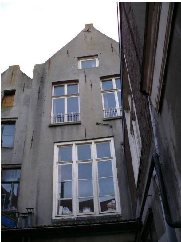
De achtergevel van Gasthuisstraat 9
