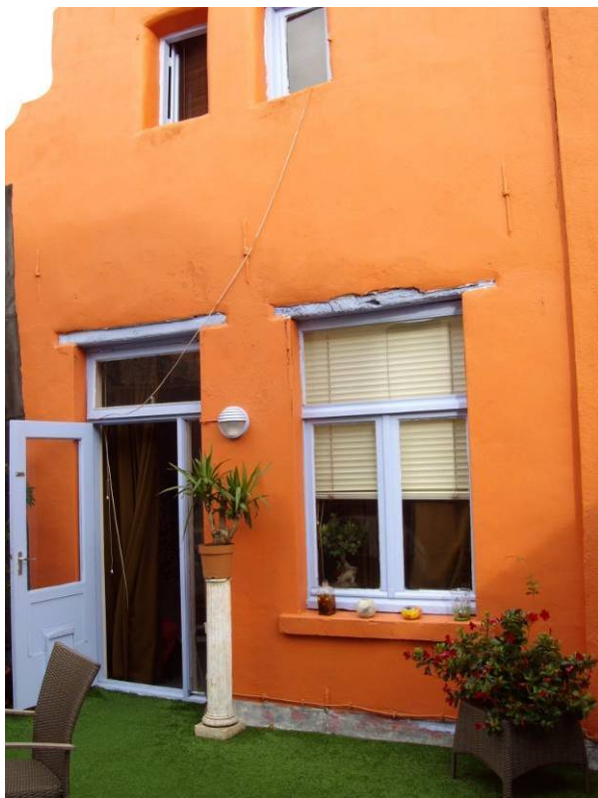
De achtergevel van nr.18 op de eerste verdieping
