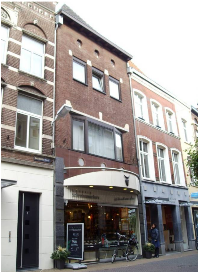
De voorgevel van Gasthuisstraat 3
