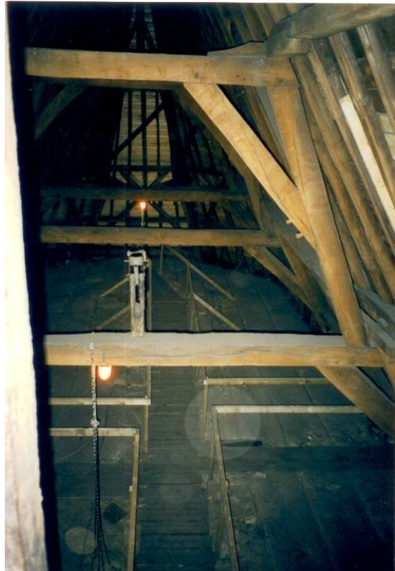
Kap van het koor van de St.Joriskerk richting het oosten
