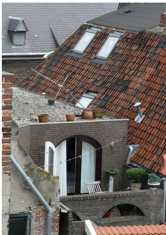
De achtergevel van Gasthuisstraat 16
