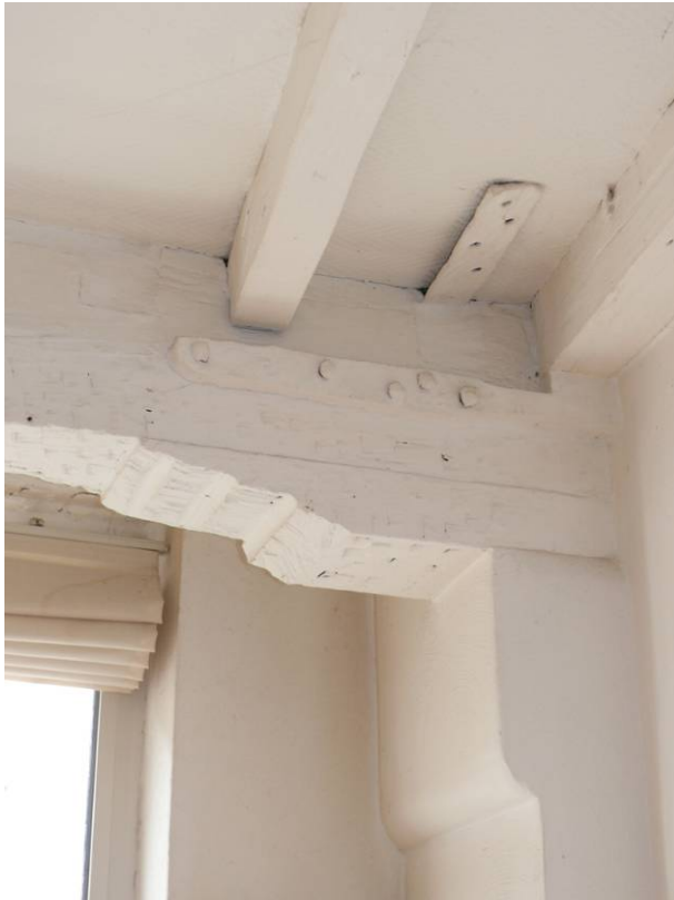
Sleutelstuk met afgehakt rondstaafprofiel bij voorste strijk balk op de eerste verdieping
