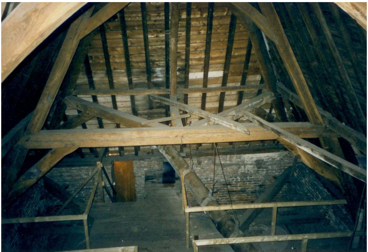
Kapconstructie van het schip van de St.Joriskerk, bij de westelijke eindgevel
