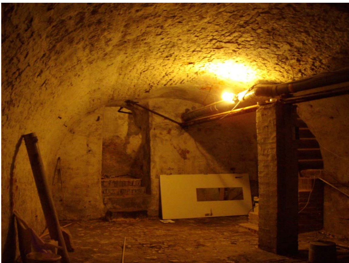
De voorkelder van Gasthuisstraat 10 richting de achtergevel en doorgang naar de achterkelder
