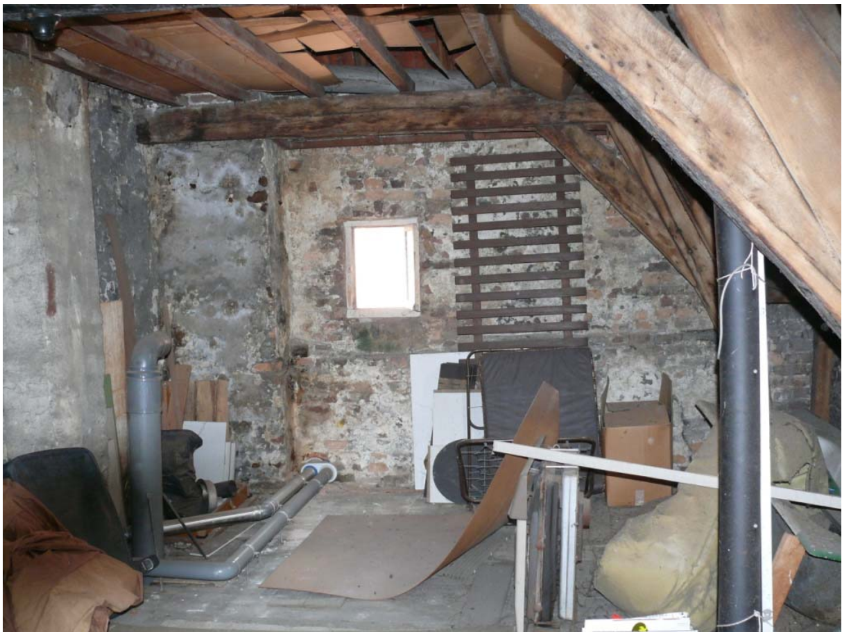
Overzicht van de kapconstructie richting de achtergevel
