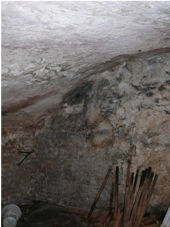
De kelder van Gasthuisstraat 2 met bakstenen tongewelf
