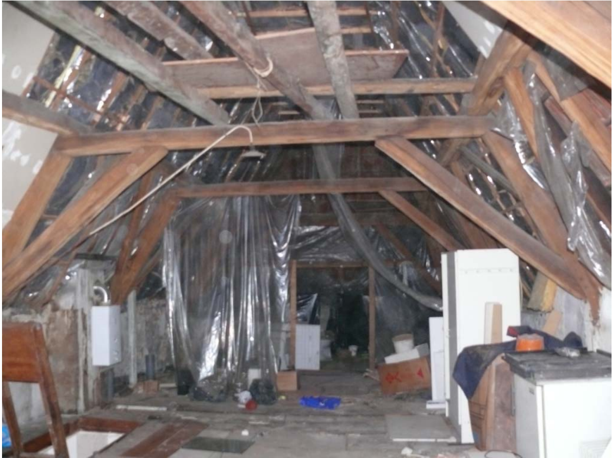
De kapconstructie van Gasthuisstraat 5 richting achtergevel
