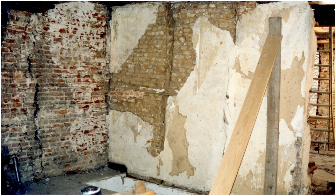
Vakwerkwand uit ca.1600 op de tweede verdieping, tijdens de meest recente verbouwing omstreeks 2000
