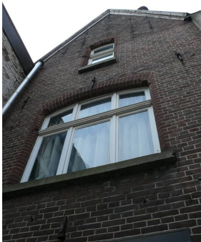
De achtergevel van Gasthuisstraat 1
