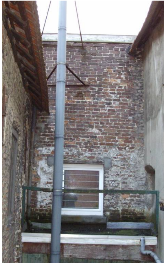
De achtergevel van Gasthuisstraat 7
