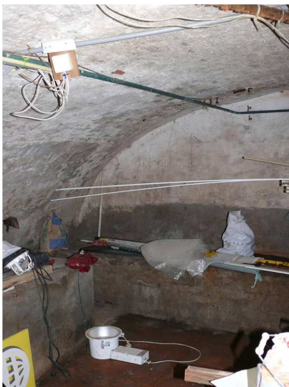
Zuidwesthoek van de kelder
