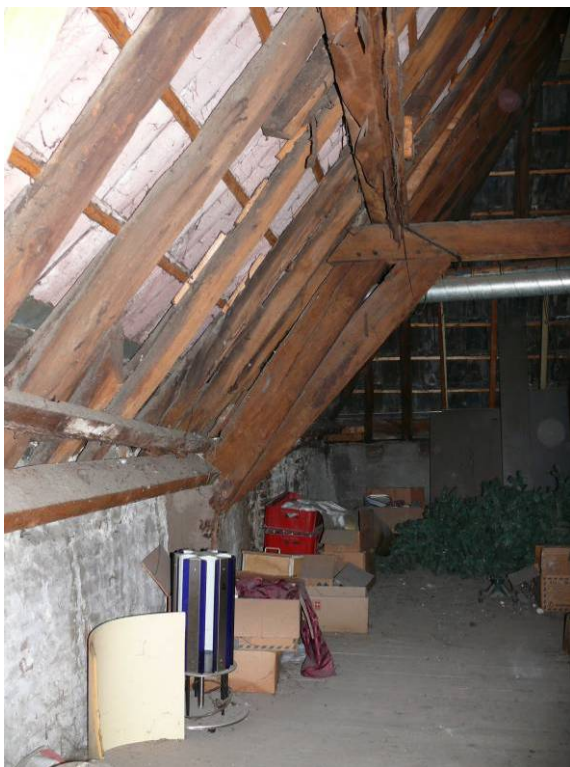
Spantbeen van het 'halve' kapsant
