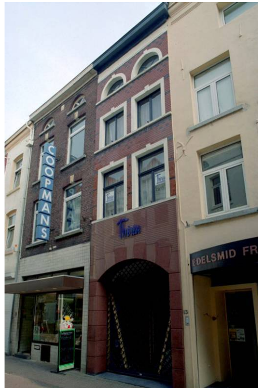
De voorgevel van Gasthuisstraat 11
