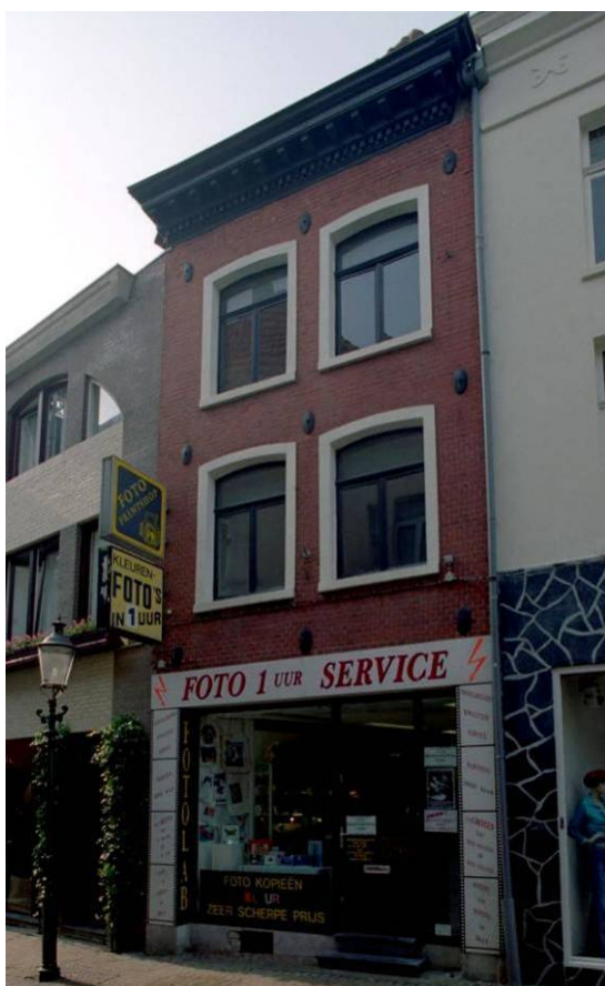
De voorgevel van Gasthuisstraat 14
