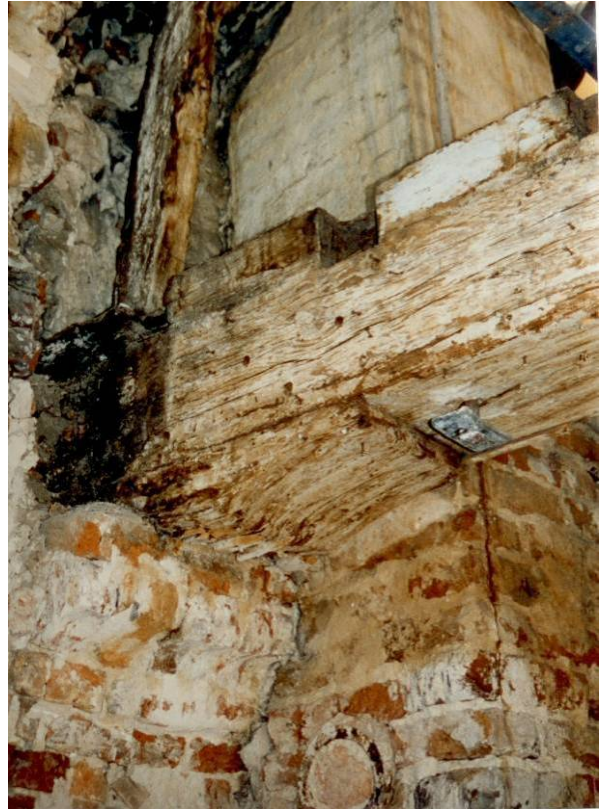
Balkoplegging met slof en bakstenen console op tweede verdieping, tijdens de laatste renovatie van het pand
