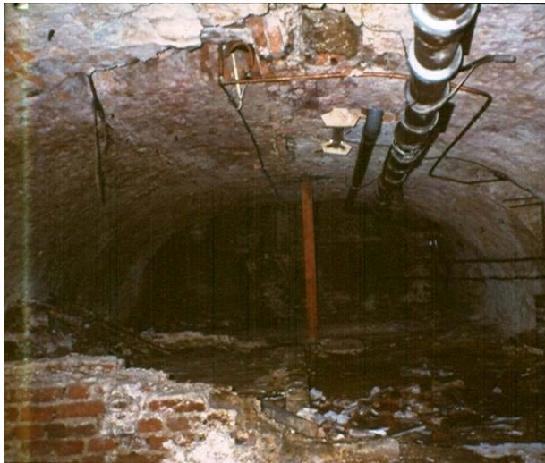
De voorkelder richting de voorgevel (1993)
