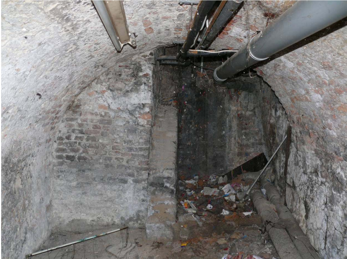
De kelder van Gasthuisstraat 4 richting de voorgevel
