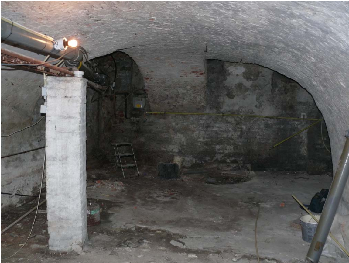
De voorkelder van Gasthuisstraat 10 richting de voorgevel
