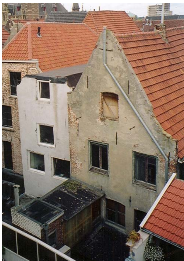
De achtergevel van Gasthuisstraat 14
