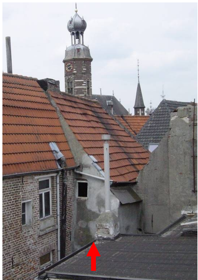
De achtergevel van nr.6, links de achterbouw van Vleesstraat 1
